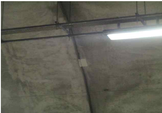
라이닝 SPAN.11 조인트부 박리 보수현황
