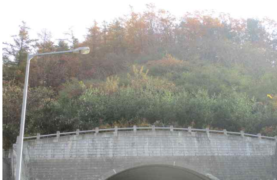
시점부 사면 전경
