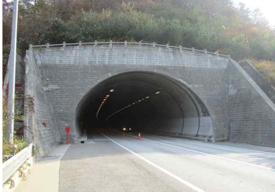
시점부 옹벽 전경
