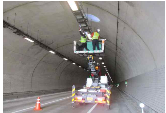
고소작업차를 이용한 외관조사 현황①
