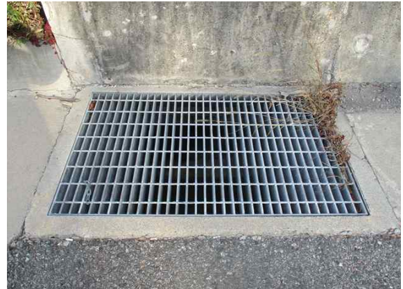
배수시설 집수구 상태양호
