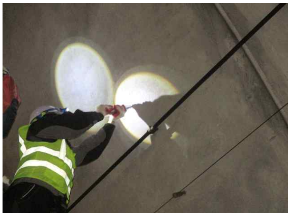
반발경도 측정 현황(천단부)
