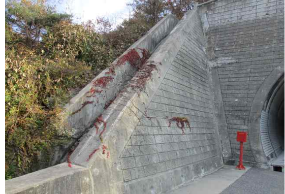
시점부 옹벽 상태양호
