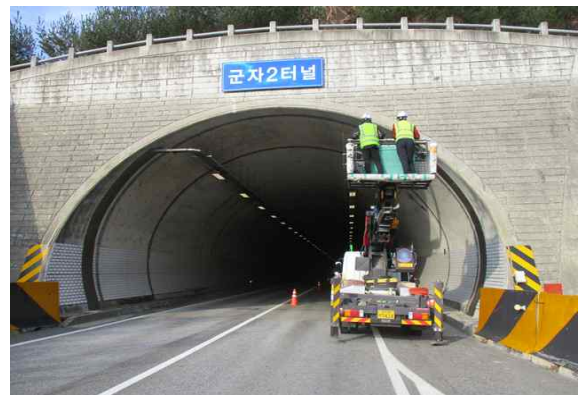
고소작업차를 이용한 외관조사 현황(갱문부)
