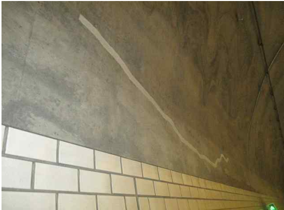
라이닝 SPAN.6 측벽부 균열보수현황
