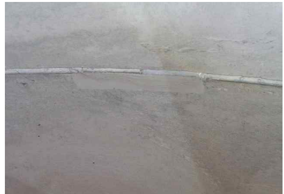
라이닝 SPAN.72 조인트부 박리 보수현황
