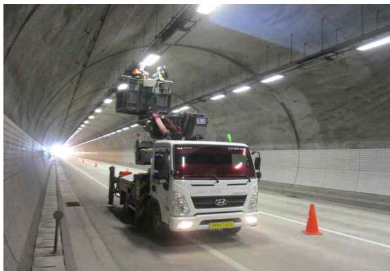
고소작업차를 이용한 외관조사 현황②
