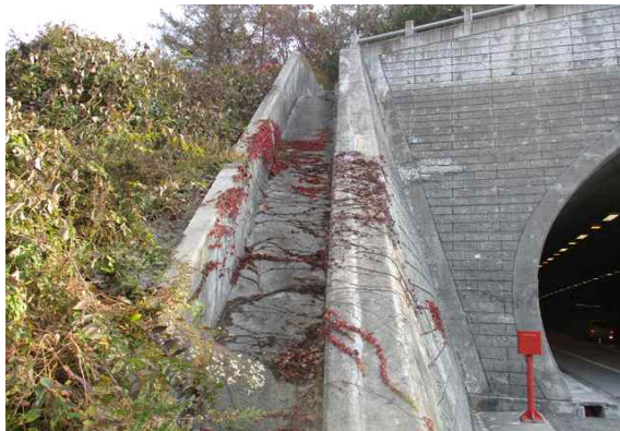
시점부 도수로 전경
