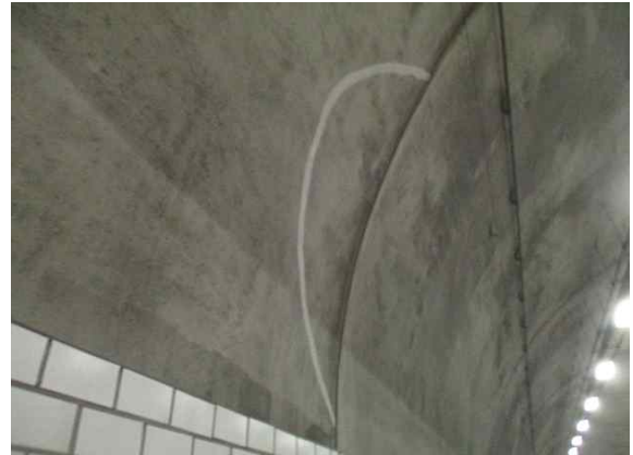
라이닝 SPAN.12 측벽부 균열보수현황
